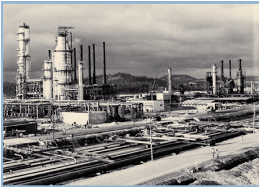
A refinaria Duque de Caxias (Reduc), no Rio de Janeiro, foi a primeira construída pela Petrobras; a inauguração foi em 1961
