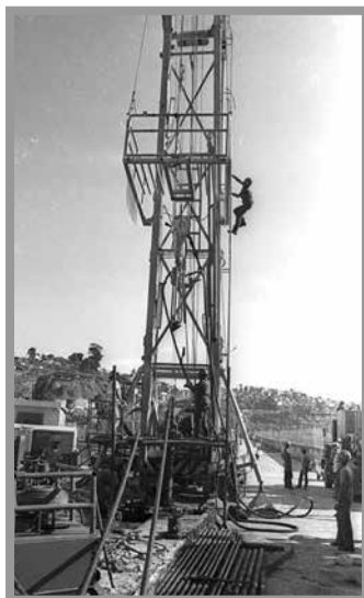
Operação do primeiro poço
